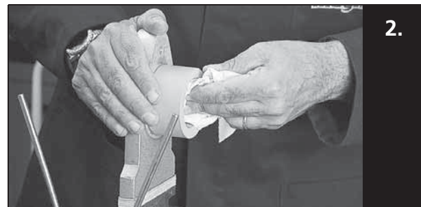
2. Reinig de lasmof en lasdoorn met MEK of spiritus op een pluisvrij, niet schurend of gekleurd papier.
