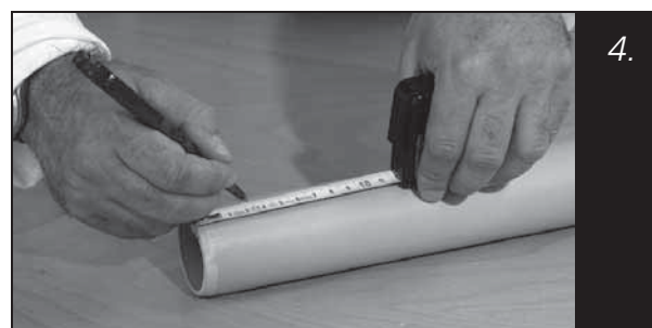
4. De mofdiepte markeren op de leiding
