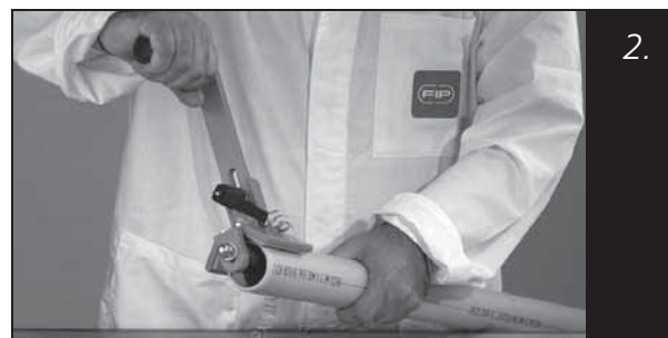
2. Zorg ervoor dat de inwendige bramen worden verwijderd met behulp van een afbraammesje. De leiding dient uitwendig te worden voorzien van een zoekrand. Dit kan worden bereikt door gebruik te maken van een afschuinapparaat.
