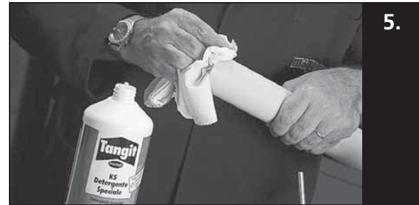
5. Maak de lasoppervlakken schoon met een reinigingsmiddel zodat vet- en stofresten van de leiding en mof verwijderd zijn.
