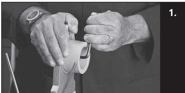
1. Plaats de lasmof en lasdoorn type B van de te lassen diameter op het verhittingselement.
