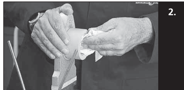
2. Reinig de lasmof en lasdoorn met MEK of spiritus op een pluivrij, niet schurend of gekleurd papier.
